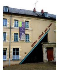
Façade du nouveau bâtiment
